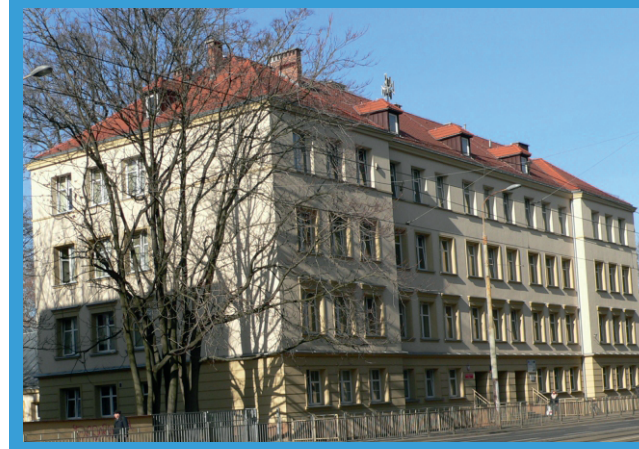
Budynek B – ul. Kofłataja 1-6
